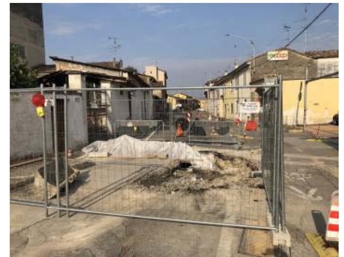
Le transenne che circoscrivono il cantiere di Padania Acque
